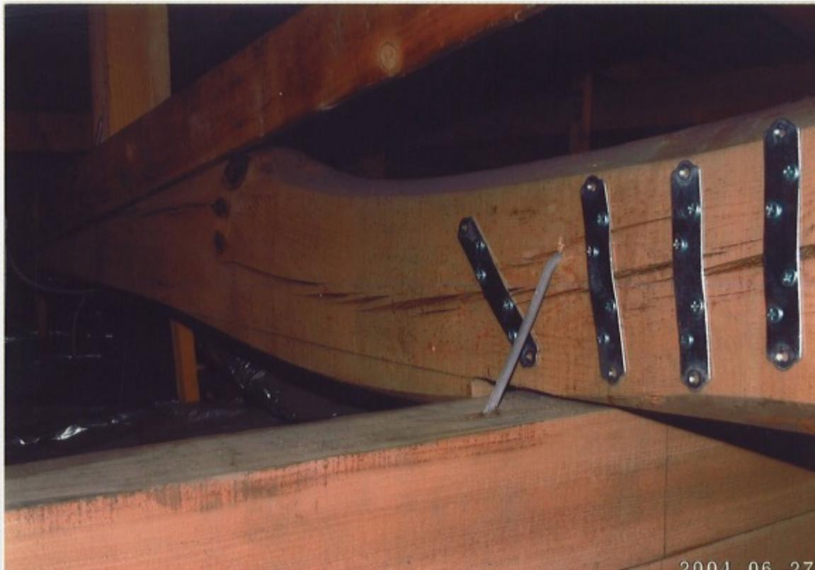
梁に経年劣化による割れが生じているが、構造上金物取り付けをしても、補強の意味がない。
